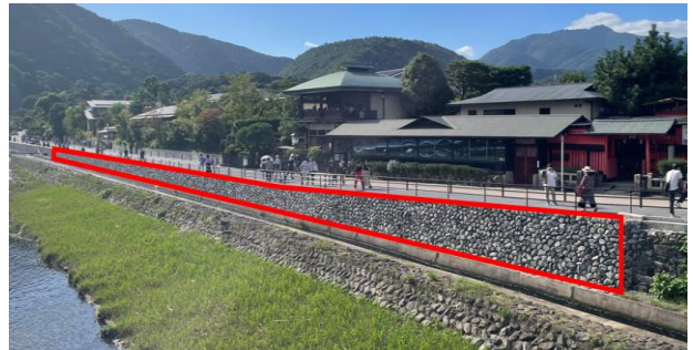
図-1 可動式パラペット（赤枠で囲んだ部分）
