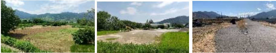
震堤内の土地利用(左②:田畑、中③:事業所、右④:上流端(太陽光発電所))
