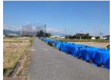
土嚢の設置状況⑥
