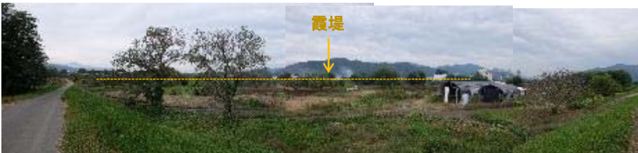
千曲川右岸堤防上からの震堤エリアパノラマ写真① 写真左、右が右岸本堤、左奥の一段低くなっている箇所が震堤の開口部
