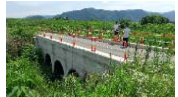
震堤の開口部の東林坊川流入部⑤
