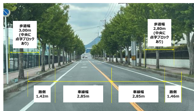
図-1 調査した道路と横断歩道の幅
