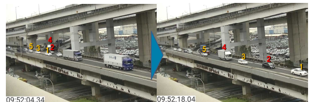
図-16 速度低下時における合流部の状況
