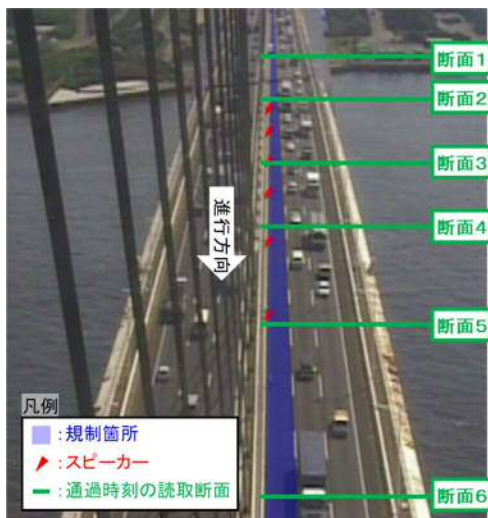
図11 CCTV画像と計測断面
