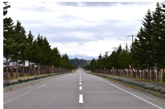
写真-4 並木により電線電柱を隠している事例
