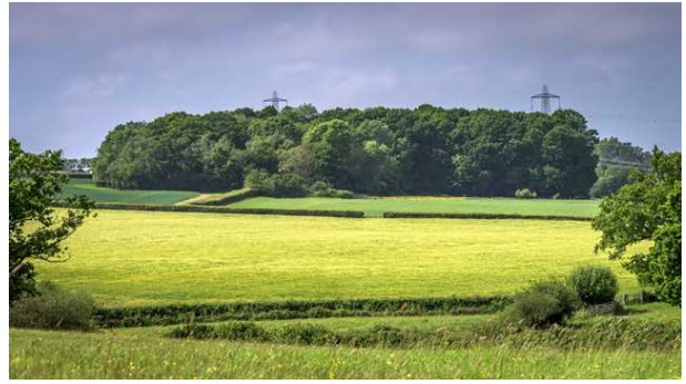
写真6 森林を造成し送電線を隠している事例 (High Weald Area of Outstanding Natural Beauty) 出典：nationalgrid 社 HP 10)
