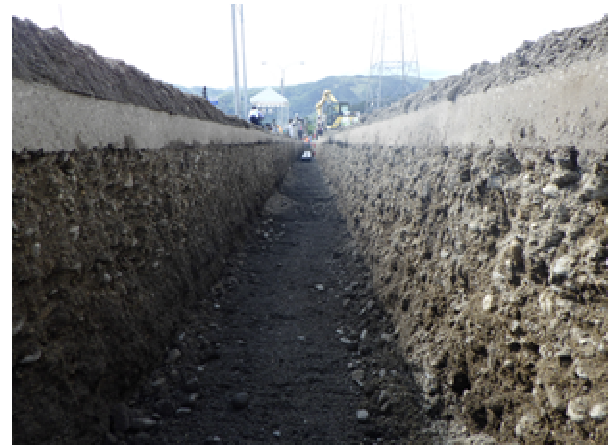
写真-2 掘削後の仕上がり
