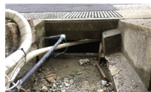
図-16 側溝活用写真 (撮影：みち研)
