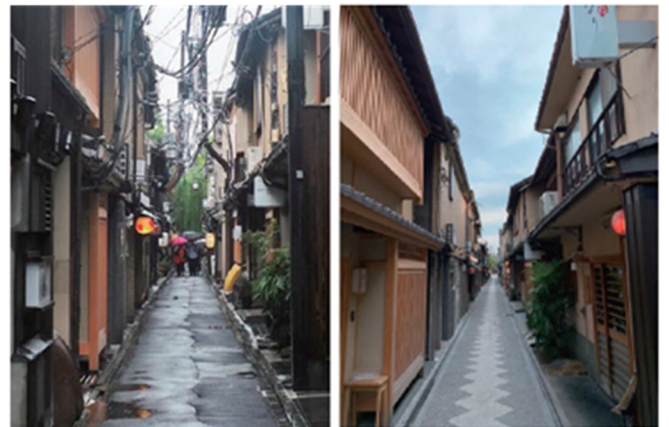
工事前 電柱抜柱後
