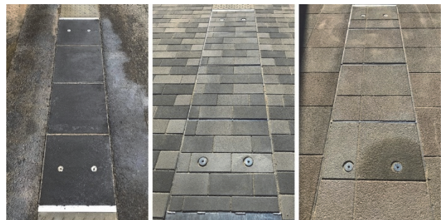
図-8 試験施工された小型 BOX の軽量鋼製蓋
