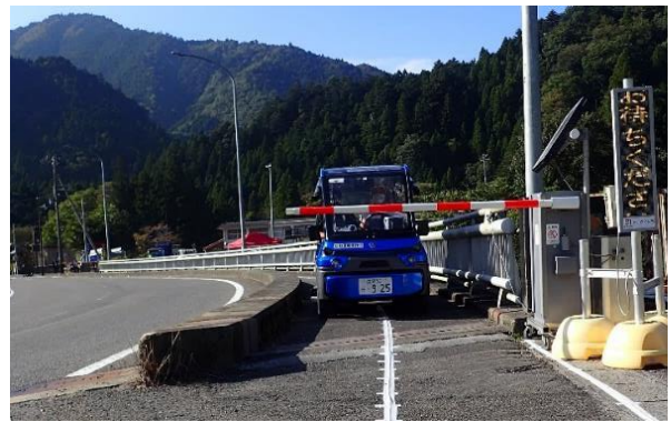
図-2 遮断ゲート及び電光掲示板写真
