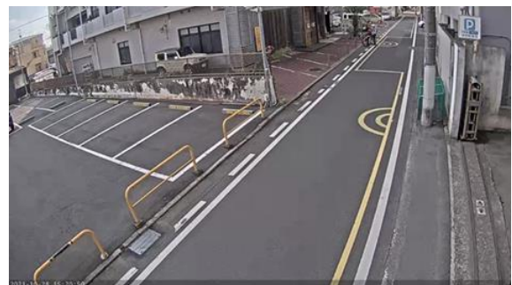
図-4 区間1の路面サイン施工時の様子
