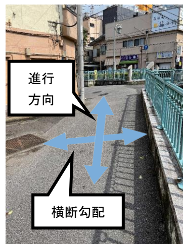
図-8 横断勾配が大きい道路
