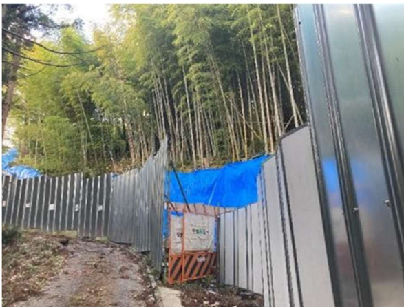
写真-5 (事例4) 地山掘削部のシート養生と仮囲いの状況 (2021年11月, 静岡県伊東市, 筆者撮影)
