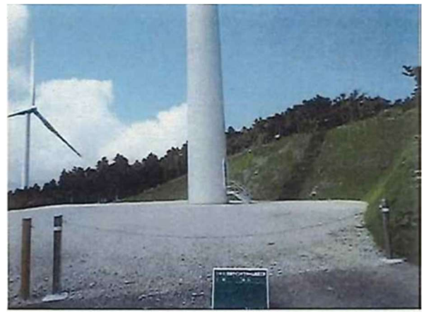
写真-6 (事例5) 風車部の平地整正と切土法面部の植生状況 (2015 年, 静岡県河津町, 静岡県提供)
