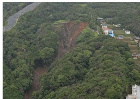
写真-1 (事例1) 土石流が発生した溪流源頭部の状況 (熱海市伊豆山地区土砂災害, 2021年7月, 静岡 県提供)
