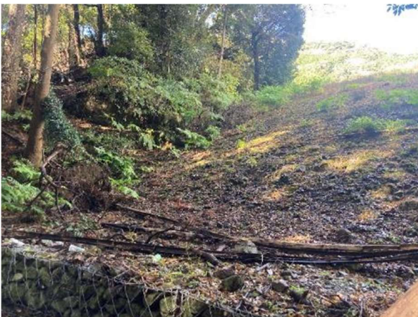
写真-4 (事例3) 盛土法面部の植生状況 (2021年12月, 静岡県賀茂郡松崎町, 筆者撮影)
