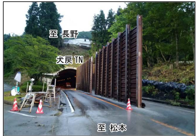
図-2 H型鋼製防護柵設置等の応急復旧状況
