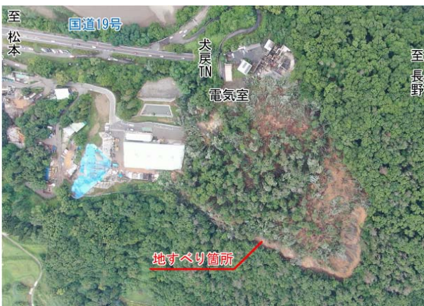
図-1 地すべり被害状況
