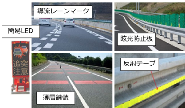
図-1 中央道上路線談合坂スマート～上野原で殉職事故を受けて実施した緊急事故対策の例（イメージであり、同区間の写真でないものがある）
