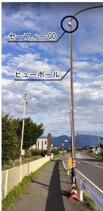
図-6 現地での照明柱へのビューポール設置状況
