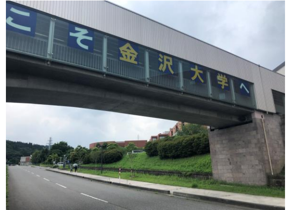
図-7 対象橋梁の一部（1 径間）
