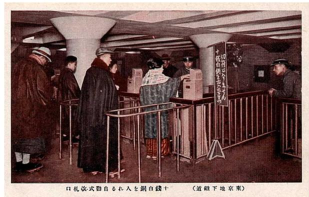
写真-2 ターンスタイルの自動改札装置
