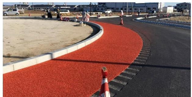
図-5 ランブルストリップス施工事例
