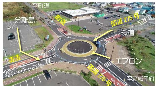
図-1 ラウンドアバウト概観
