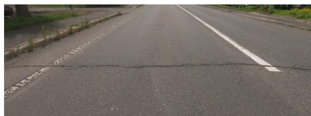
図-3 低温ひび割れの例
