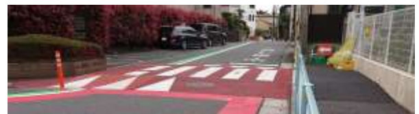
図-2 朝霞第五小学校前のスムーズ横断歩道の様子(西側から)
