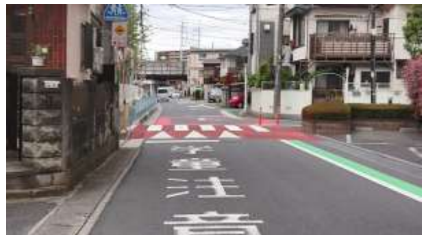
図-3 朝霞第五小学校前のスムーズ横断歩道の様子(東側から)
