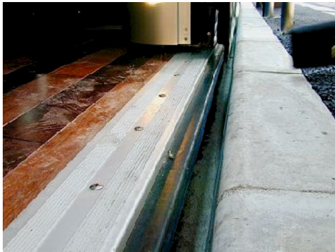
写真-1 岡山電気軌道の改良電停 (2002年撮影)
