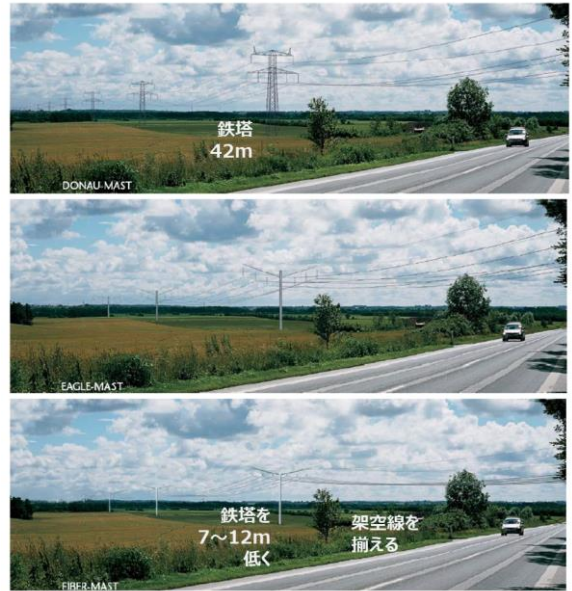
図-4 400kV 既存送電鉄塔の景観向上案 ※Cable Action Plan より転載・加筆
