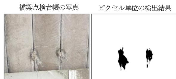
図-1 AIモデルによる遊離石灰の検出結果の例
