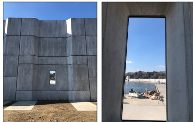
写真-1, 2 岩手県宮古市鉾ヶ崎地区の防潮堤
