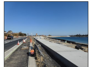
写真6 大谷海岸の防潮堤
