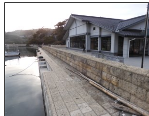
写真5 松島町の防潮堤
