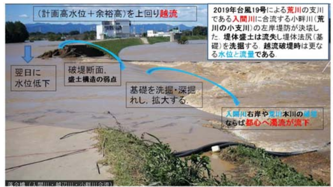
2019年台風19号翌日、入間川・小群川決壊 - YouTubeyoutube.comに破堤を注記した。
