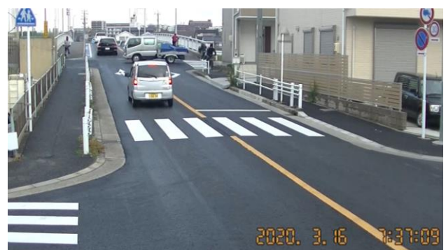
図-7 交差点内部についての現地確認
