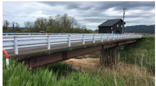
図-2 対象橋梁 R 橋の外観
