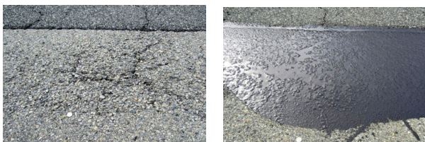
施工前 施工後 写真-3 常温型簡易補修材の検討
