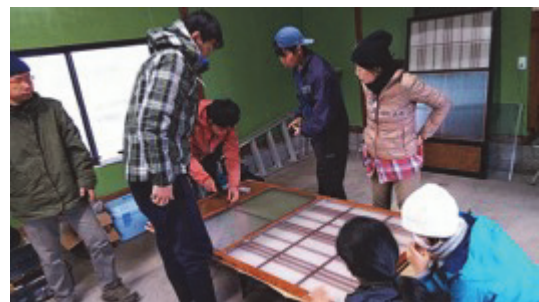
写真-1 建具の2重窓作業の様子
