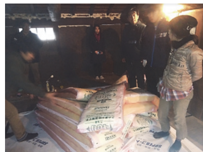
写真-2 屋根裏の断熱材敷作業の様子
