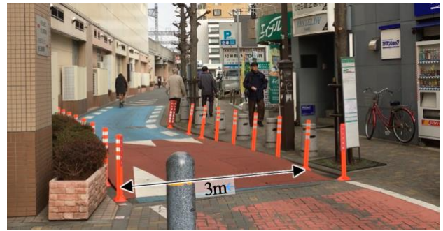
図-1 ハンプの設置状況
