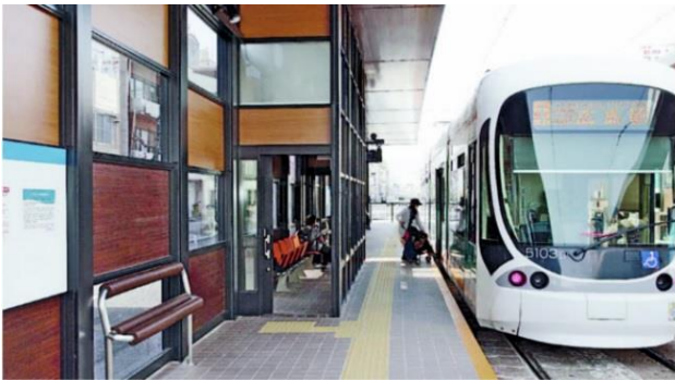
図-7 改修され待合室電停になった広島電鉄広電本社前電停（広島市中区）
