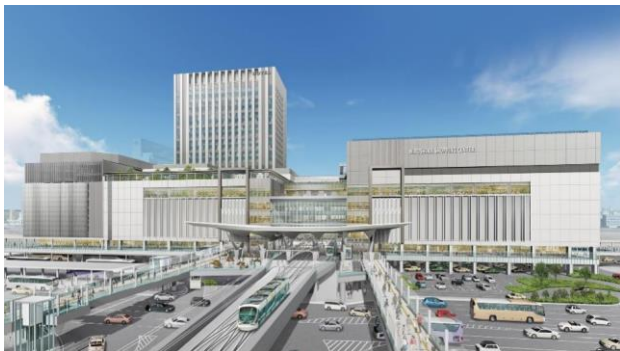
図-1 JR 広島駅に高架で乗り入れる路面電車のイメージ (広島市提供)
