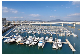
写真-1 係留保管施設
