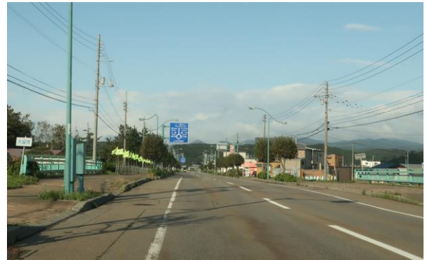
図-15 ラウンドアバウトの手前に道路標識(写真中央)を置いて運転者に認知させる例(北海道上ノ国町)
