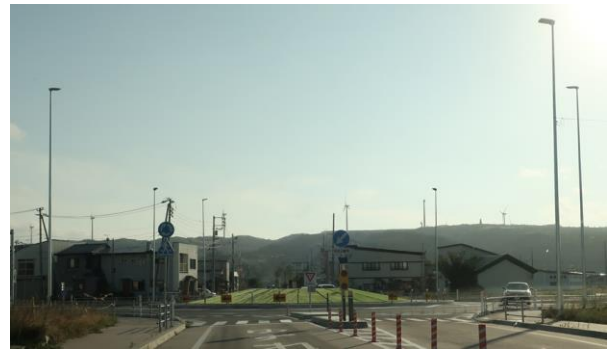
図-14 中央島のマウンドを高くすることにより対面見通しを無くした例(北海道上ノ国町)
