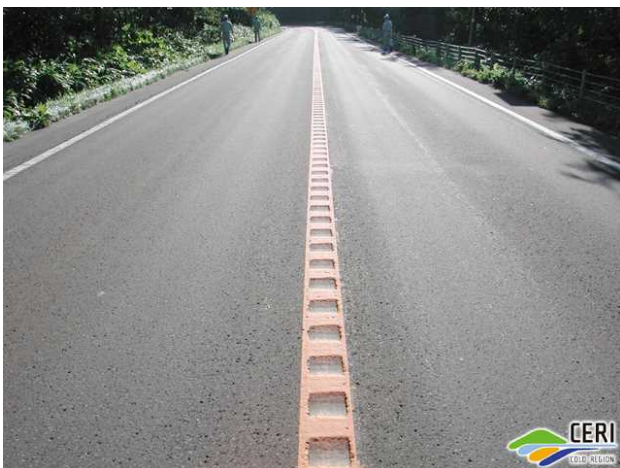
写真-2 ランブルストリップス (寒地土木研究所 HP より)
