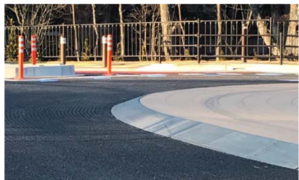
図-7 エプロン設置状況
