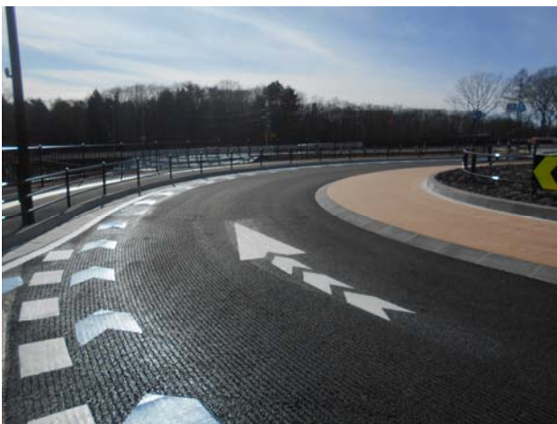
図-9 多機能排水性舗装の設置状況
