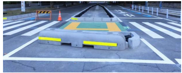
図-10 幅広分離島、先端形状、強固な置式基礎ブロック
