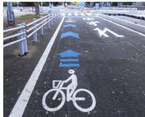
図-8 車線（自転車通行空間を含む）とガードパイプ
