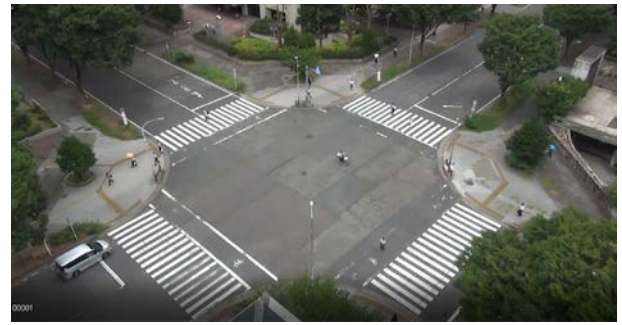
図-2 整備前の交差点状況
