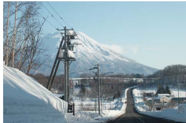
写真5 地域景観の魅力的を低下させている電線電柱類
