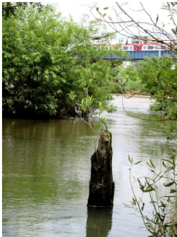
写真-10 B-1（下流側、青は上流の名鉄矢作川橋梁）
