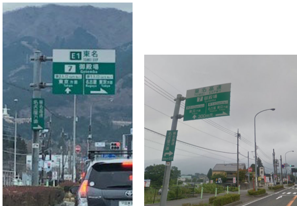
図-5 御殿場 IC 東京方面専用入口部手前 (左) および 300m 手前 (右) に設置された案内標示
