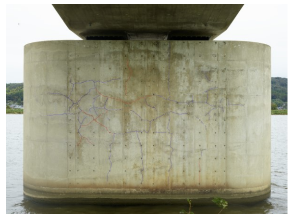
図-5 近接目視点検結果から作成した正解データ
