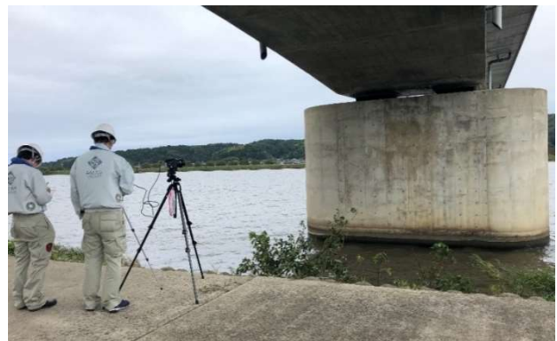
図-1 高解像度カメラでの橋脚部の撮影の様子
