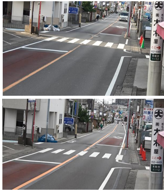
図-1 路側帯拡幅社会実験調査地点の様子（上：実験前，下：実験中）
