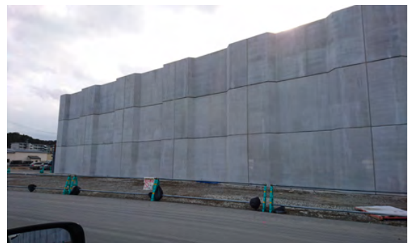
写真-5 新設された防潮堤
