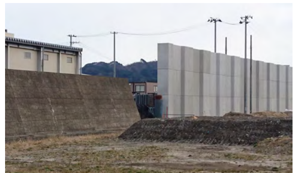
写真-4 既存防潮堤 (左) と新設防潮堤 (右)
