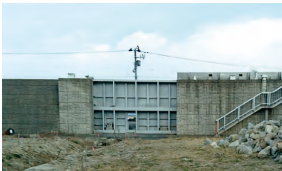
写真-1 防潮堤 (北浜地区, TP+4m)
