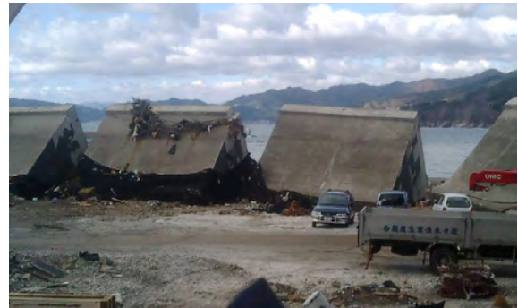
写真-2 転倒した防潮堤 (田の浜地区)
