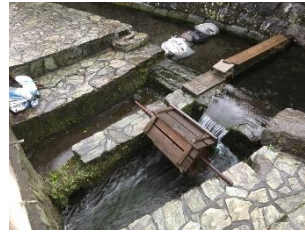
写真-9 水路内の重石(寺坂)
