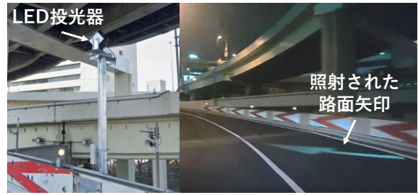
写真-1 LED投光器による路面矢印の照射状況
