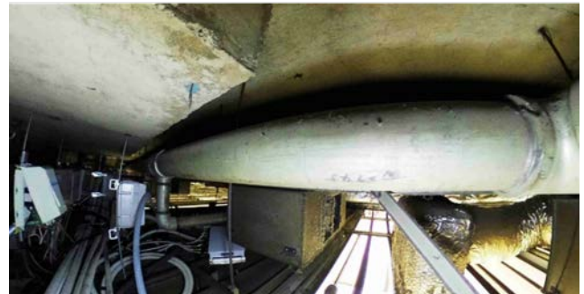
図-1 天井内部調査の全方位撮影画像
