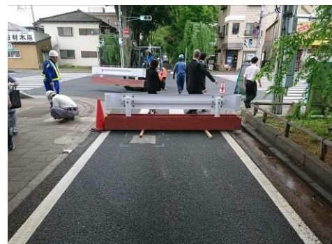
図-12 交通規制変更の様子（進入口部分）
