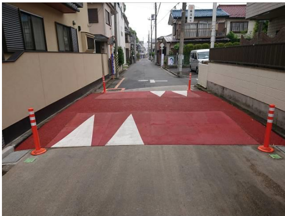
図-18 ハンプ設置結果
