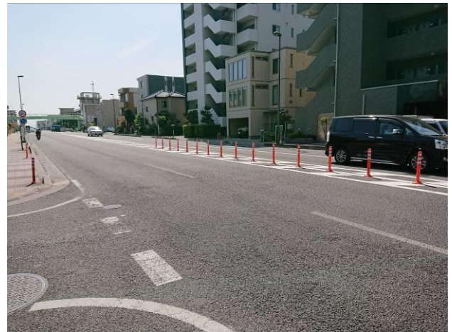
図-19 右折抑制設置結果
