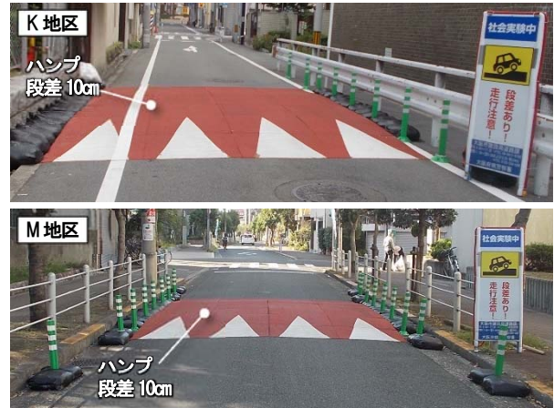
図-2 可搬型ハンブの設置状況
